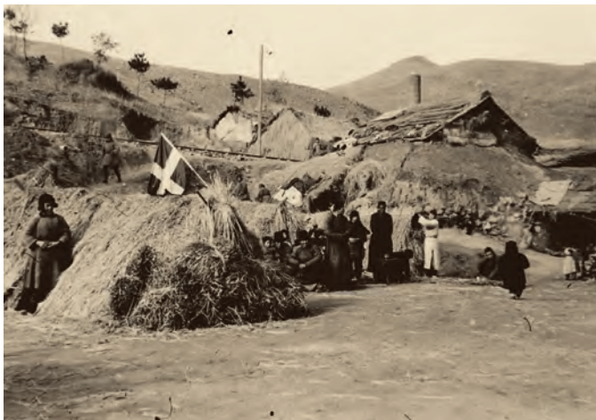
江南セメント工場に設置された難民所
